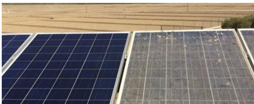
Ejemplo de suciedad extrema frente a modulo limpio
